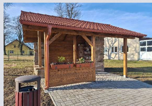
Autobusová čekárna v obci Krsy.
