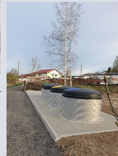
Kontejnery na separovaný odpad v obci Nevřeň.
